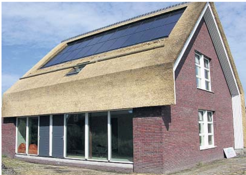
▲ De nul energiewoning in Oostindie (Leek). Foto: Archief DvHn
