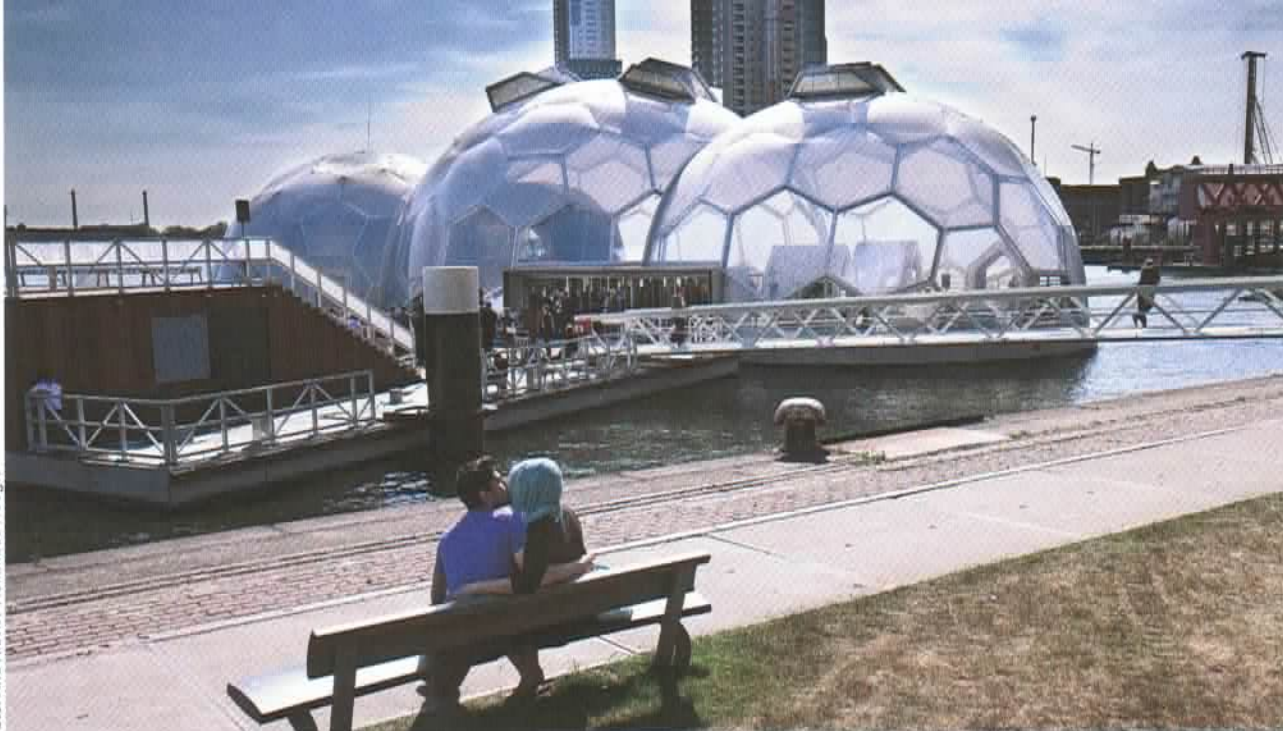
Het Drijvend Paviljoen in Rotterdam, een duurzaam initiatief waarbij Urgenda betrokken is. Het is een kleinschalig experiment dat als eerste stap dient voor een drijvende wijk en uiteindelijk een drijvende stad.
