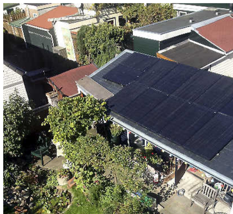
Deze zonnepanelen wekken stroom op en verhitten tegelijk water.
