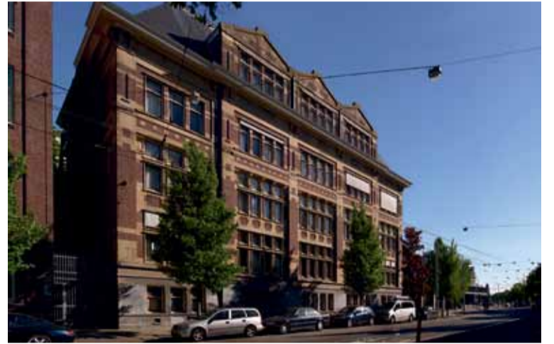
Het Concertgebouwplein 20, te Amsterdam, zal verbouwd worden door Rijnbout, in opdracht van Kroonenberg Groep. FOTOGRAFIE: KEES HUMMEL
